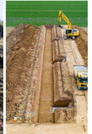
Baustraße mit Lastverteilungsplatten aus Stahl auf dem Oberboden und Abtrag des Oberbodens im Grabenbereich
