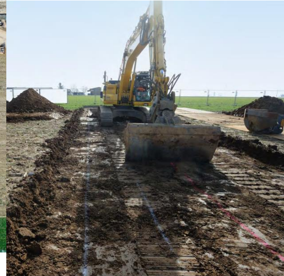
Baustraße mit Lastverteilungsplatten aus Stahl auf dem Oberboden und Abtrag des Oberbodens im Grabenbereich
